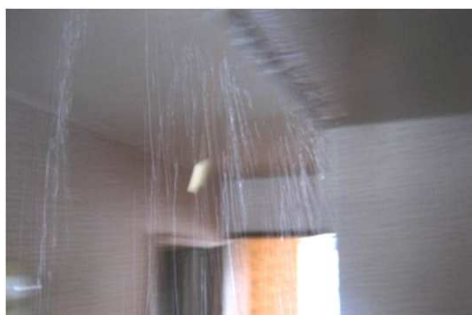
上階で水道管がパンクし、下階に生じた水漏れ
