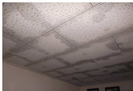
上階で水道管がパンクし、下階に生じた水漏れ
